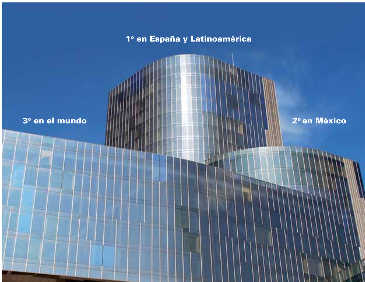
Nueva sede social de Gas Natural en Barcelona.
